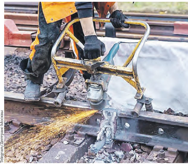
15 июня 2022 года. Укладка бесстыкового пути на Таганско-Краснопресненской линии
