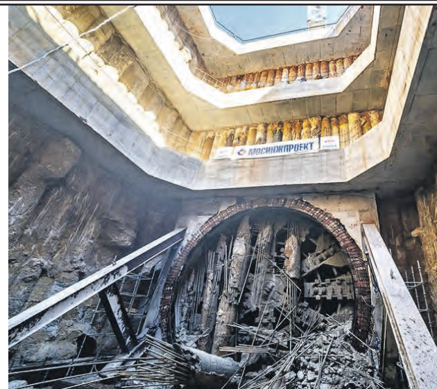
Выход 10-метрового щита «Победа» на восточном участке Большой кольцевой линии
