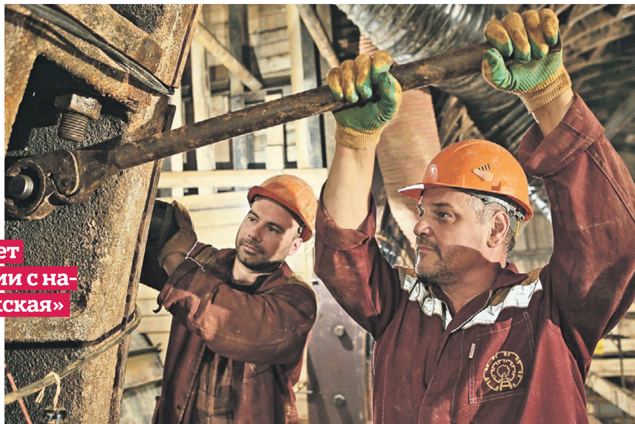
20 июля 2020 года. Большая кольцевая линия, участок Рижская-Ржевская (слева направо) подземный бетонщик Сергей Корчагин и проходчик Анатолий Магдалинский работают над сооружением наклонного хода эскалатора
