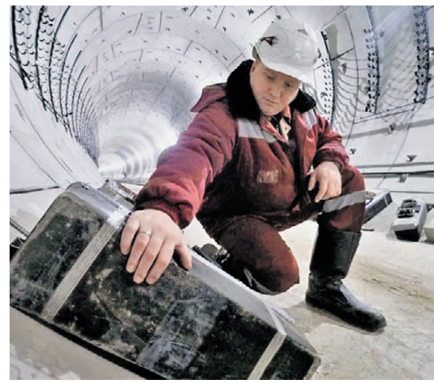
2 мая 2019 года. Заместитель начальника участка «Тоннель-2001» Вадим Мурашко на стройке БКЛ
