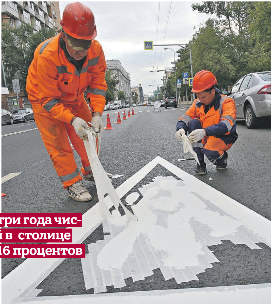
30 августа 2018 года. Рабочие наносят разметку на Большой Пироговской улице
