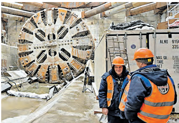
5 февраля 2018 года. Метростроевцы около щита «Лилия», проложившего тоннель до «Юго-Восточной»
