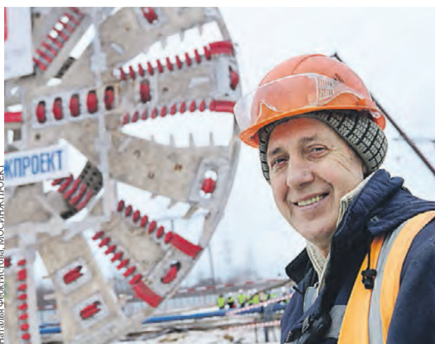
▶ 23 декабря 2016 года. Проходчик Александр Гурьев во время подготовки пуска 10-метрового щита
