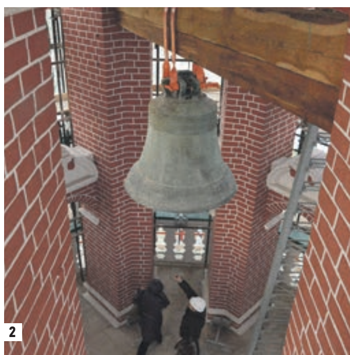
25 декабря 15:45 Вид на Новодевичий монастырь с верхнего яруса реставрируемой колокольни (1) Колокол известного мастера Кирилла Самойлова, отлитый им в 1629 году, чудом уцелел при пожаре в марте 2015 года (2)
