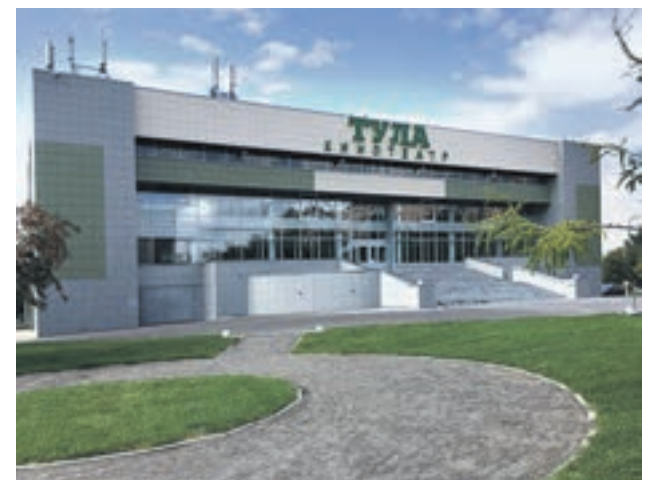
2 ноября 2017 года. Самый большой столичный кинотеатр «Тула» открылся после капитального ремонта
