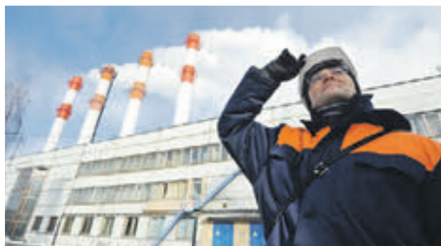
Московские котельные готовы запустить по первому сигналу. Фото 2014 года
