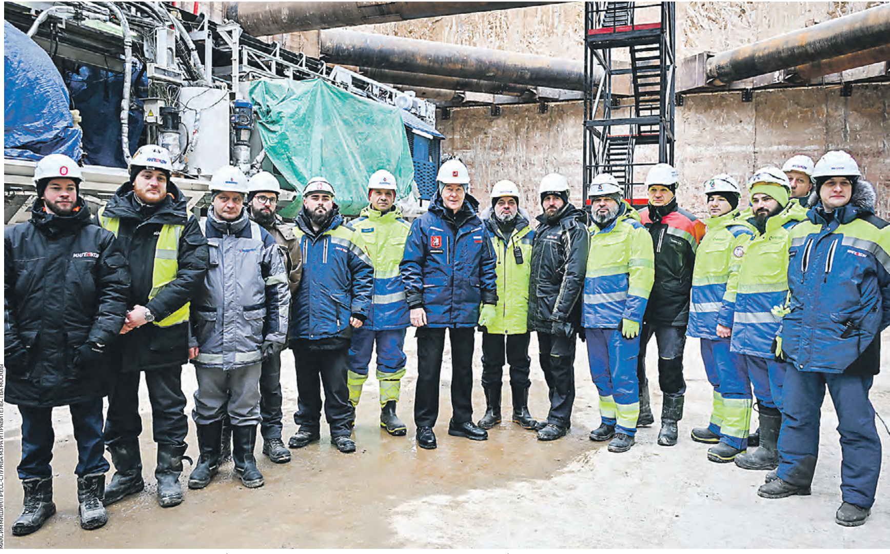
17 февраля. Мэр Москвы Сергей Собянин дал старт проходу тоннеля между станциями «Рублево-Архангельское» и «Липовая Роща» на новой линии метро. В перспективе Рублево-Архангельская ветка свяжет два деловых центра: существующий «Москва-Сити» и строящийся «Сбер-Сити»
