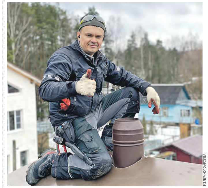
Март 2023 года. Трубочист Александр Колесников отремонтировал дымоход
