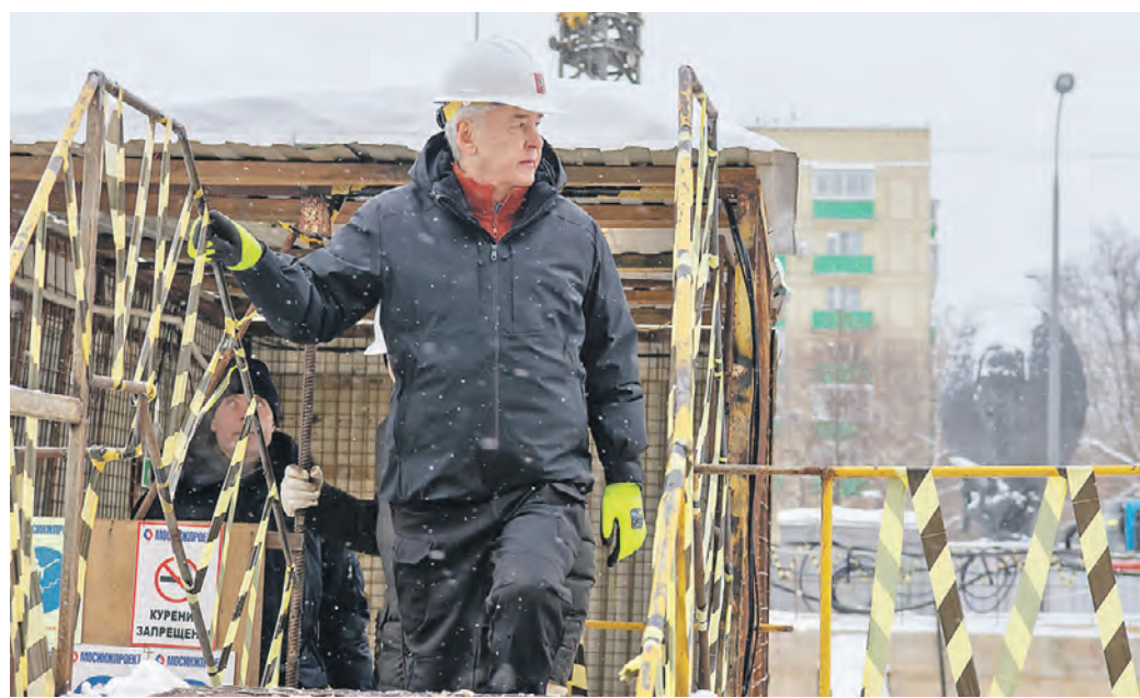
14 декабря. Мэр Москвы Сергей Собянин осмотрел ход строительства станции «Академическая» Троицкой линии Московского метрополитена
