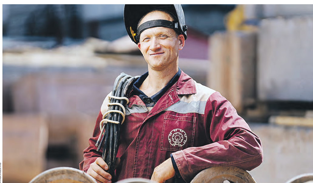
2 августа 2021 года. Электросварщик АО «Мосметрострой» Андрей Куликов работает на станции «Рижская» Большой кольцевой линии метро
