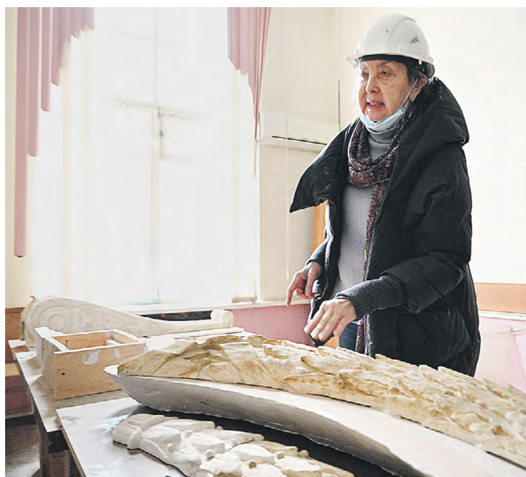
Вчера 14:52 Архитектор-реставратор Ольга Чужинова показала несколько восстановленных деталей лепного декора, который вновь украсит операционный зал Московского почтамта
