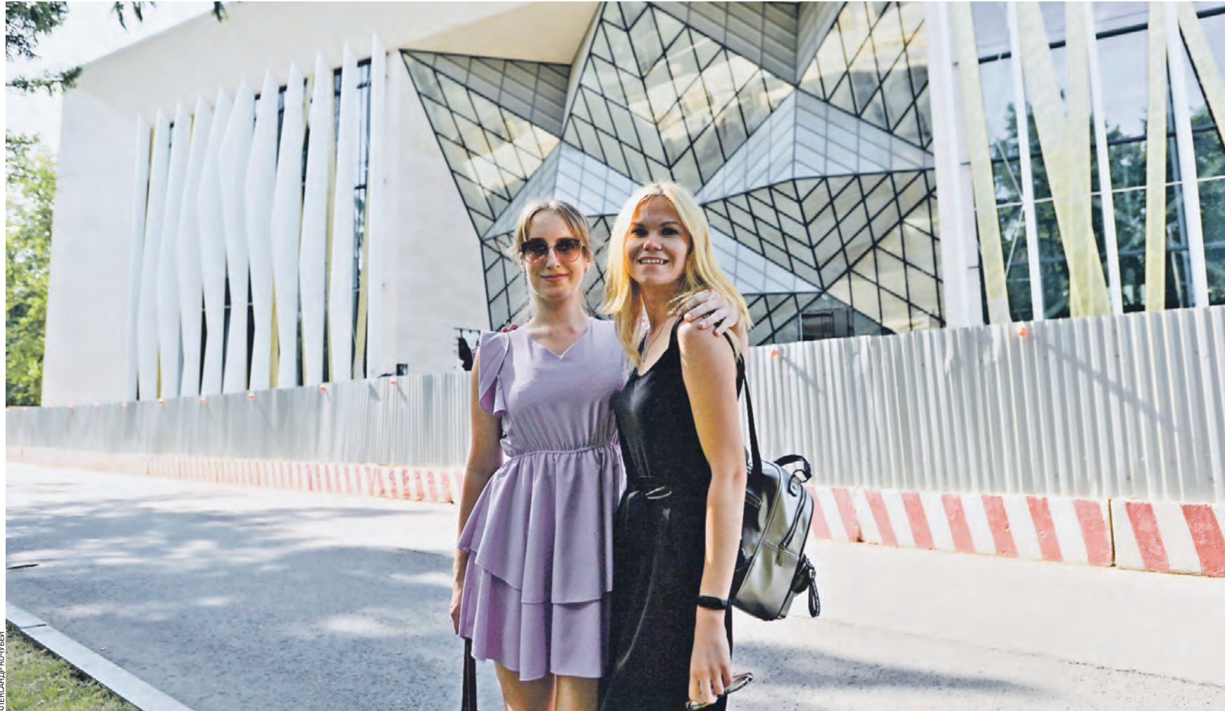
13 августа 15:16 Посетительницы олимпийского комплекса «Лужники» Наталья Кузнецова и Анна Козлова (справа) осматривают строящийся ледовый дворец. По мнению девушек, фасад здания похож на кристаллы льда
