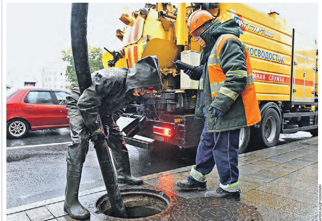
Вчера 15:19 Слесарь аварийно-ремонтной бригады Алексей Козлов (слева) и водитель Алексей Казьмин прочищают ливневую канализацию в Таганском районе
