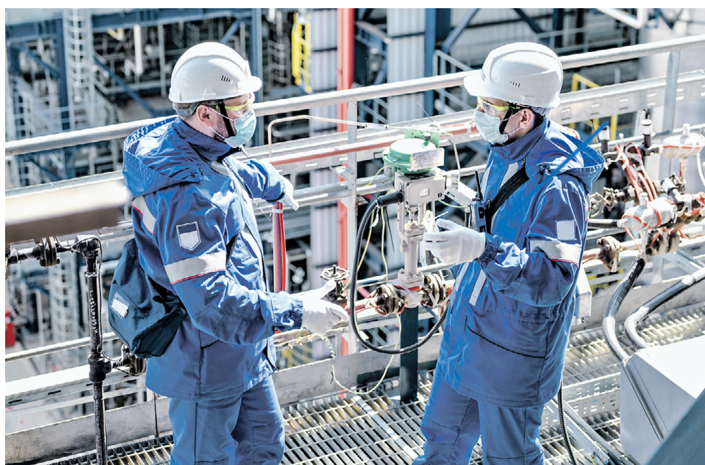
Оператор технологических установок Дмитрий Сухов и ведущий специалист отдела капитального строительства Артур Сидоров на комбинированной установке переработки нефти «Евро+»
