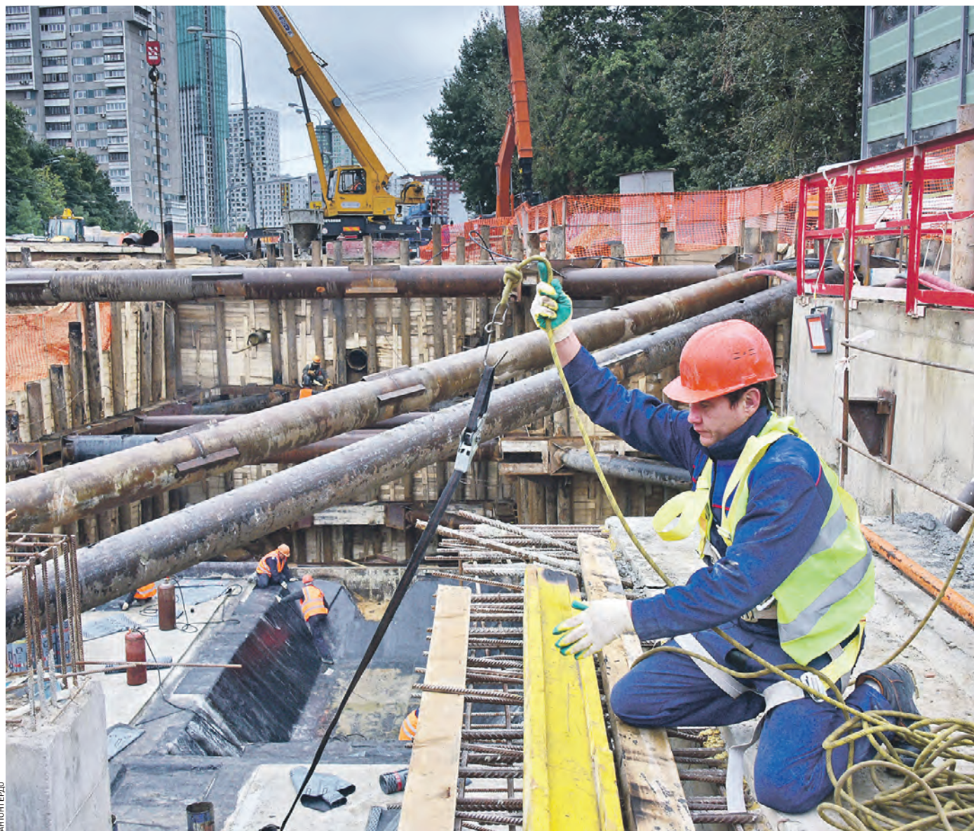
19 сентября 9:57 Рабочий Валерий Максимов на стройплощадке станции «Улица Народного Ополчения» Большой кольцевой линии метро. Сейчас здесь идет завершение основных строительно-монтажных работ
