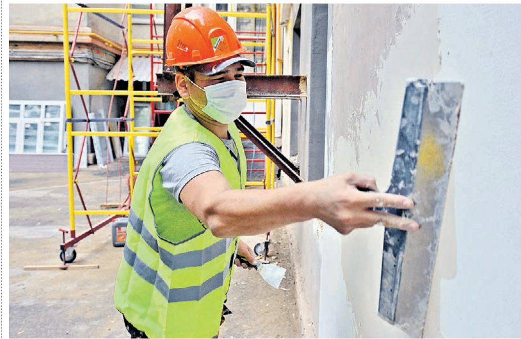
Вчера 11:51 Рабочий Александр Ревский выполняет окраску фасада дома по улице Октябрьской, 38, корпус 2, в районе Марьино Роша
