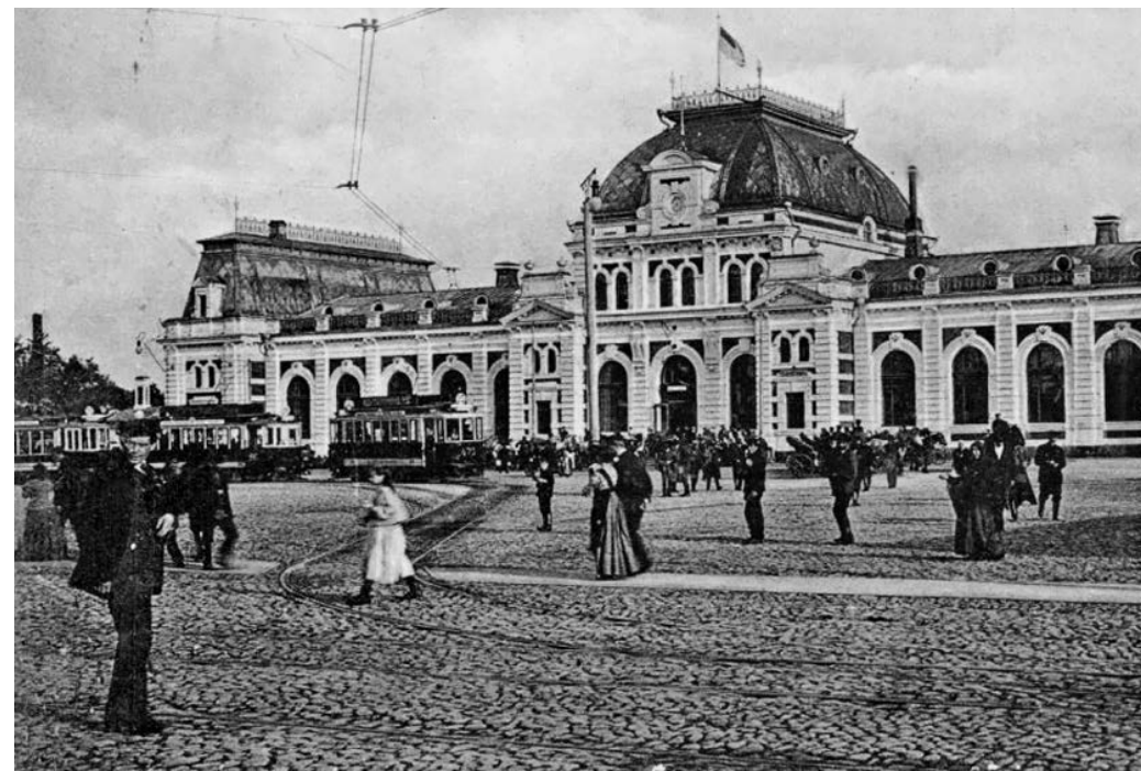
1910 год. Вид на недавно построенное здание Павелецкого вокзала, около которого в то время проходили трамвайные пути
