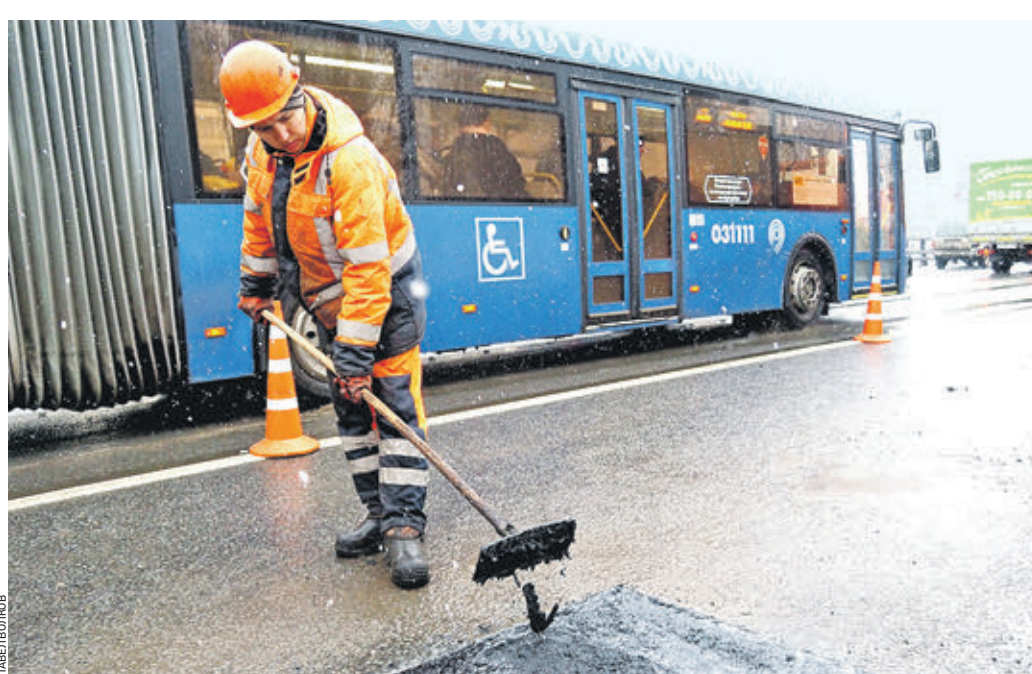
Вчера 15:28 На Дмитровском шоссе работник ГБУ «Автомобильные дороги» Константин Антропов выравнивает в яме только что положенный литой асфальт
