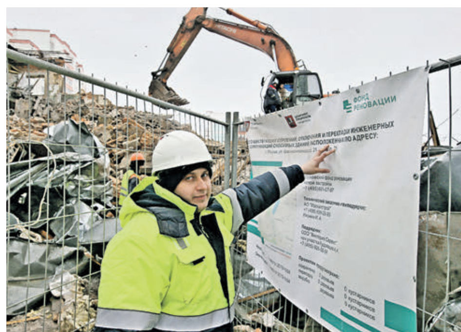
Вчера 10:07 Строители приступили к сносу дома, расселенного по программе реновации на юго-западе Москвы в районе Южное Бутово по адресу: улица Краснолиманская, 25. На фото — мастер Станислав Соколов, который руководит работами по демонтажу. Освобожденный после сноса участок передадут под застройку по программе реновации
