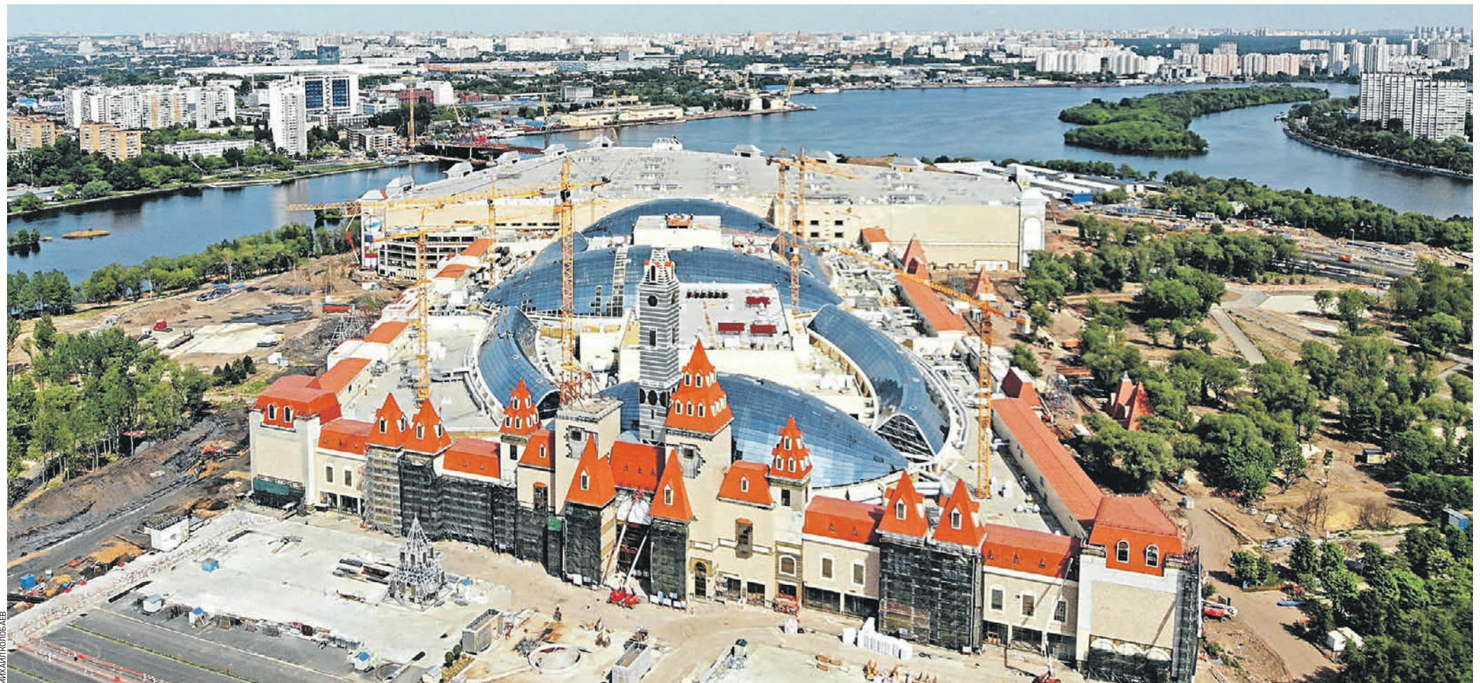
30 июля 2019 года. «Остров Мечты» почти достроен. Открытие крытого тематического парка развлечений ожидается уже в нынешнем году
