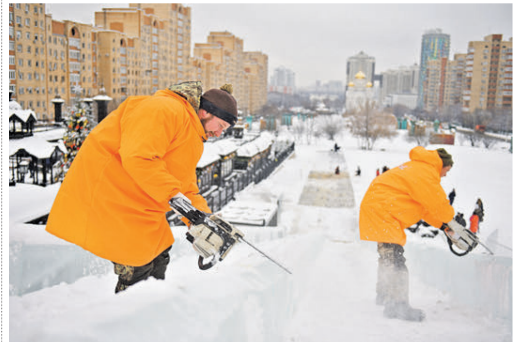
Вчера 12:34 Монтажные льда Максим Богданов (слева) и Руслан Погожев вырезают ледяные блоки для строительства горки
