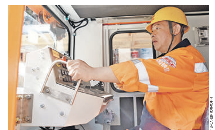
Вчера 11:34 Специалист китайской подрядной организации на запуске тоннелепроходческого щита
