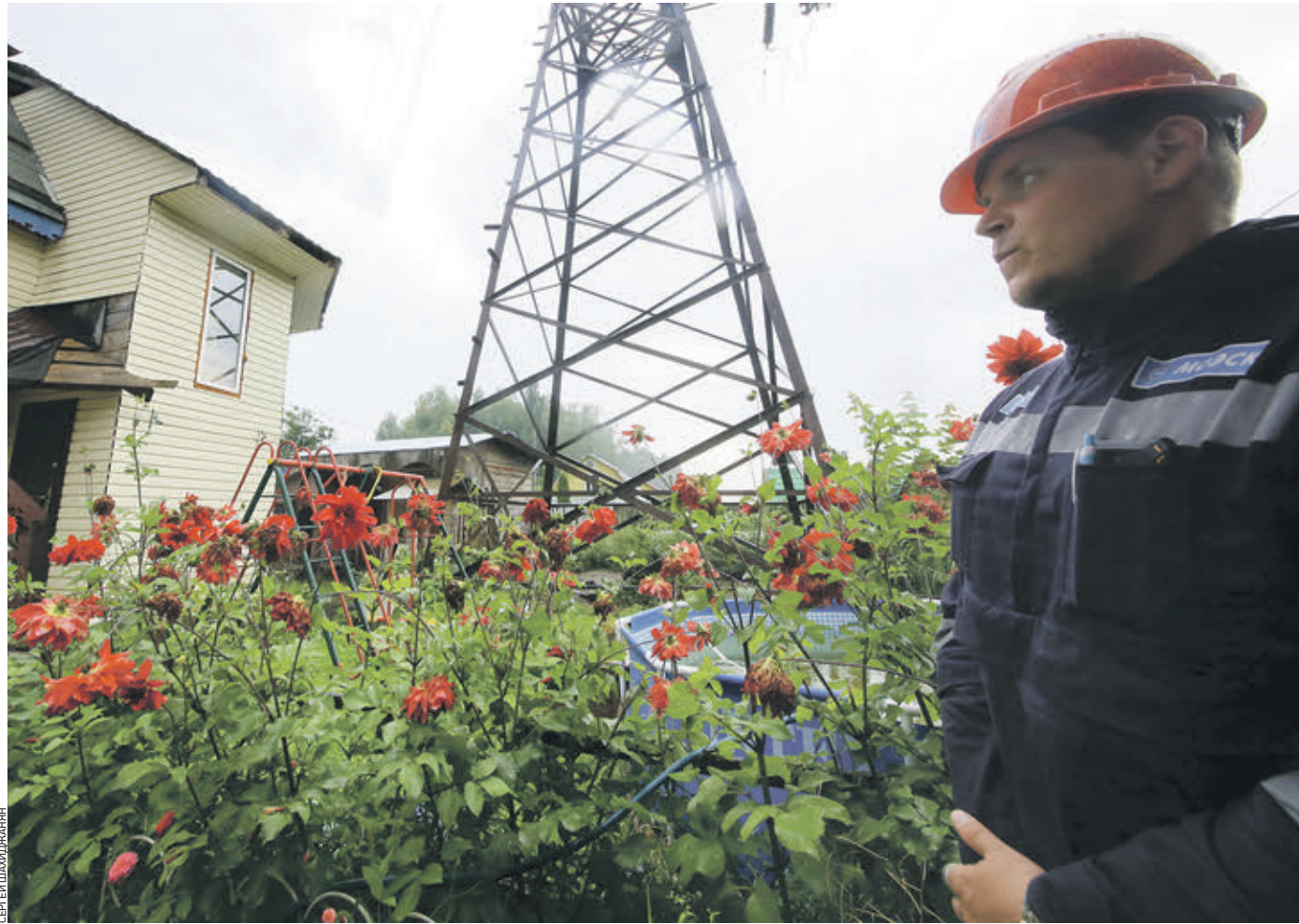
Вчера 13:34 Мастер службы линий Илья Митраков осматривает опору ЛЭП, которая находится на территории садового товарищества. Здесь, по закону, никаких строений в радиусе 20 метров не должно быть
