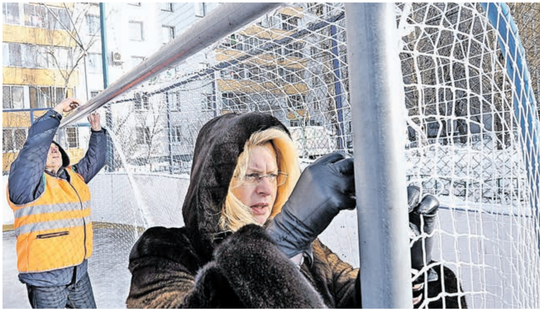
Вчера 10:20 Заместитель главы управы Люблино по жилищно-коммунальному хозяйству Ольга Лебедева проверяет, насколько прочно прикреплена на воротах новая сетка. Ее восстановили после жалобы жительницы района Люблино на портале «Наш город»
