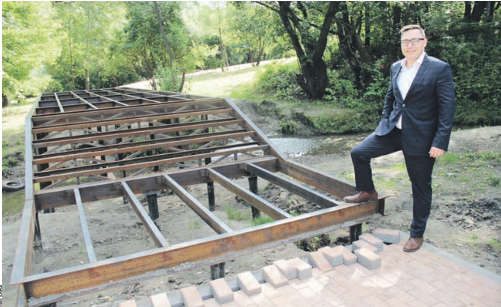
Вчера 10:23 Глава управы района Зябликово Константин Князев показывает, как продвигается благоустройство народного парка. На фото он стоит у строящегося моста, который соединит берега речки Шмелевки
