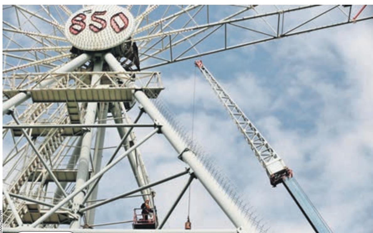
Вчера 11:50 Во вторник рабочие приступили к финальной стадии демонтажа колеса обозрения на ВДНХ, которая продлится до конца июня. Колесо вращают на несколько градусов против часовой стрелки и после каждого оборота отсоединяют нижнюю секцию. В процессе работ выяснилось, что на болтах и других элементах конструкции нет клейм завода-изготовителя с обозначением класса прочности, что является грубым нарушением
