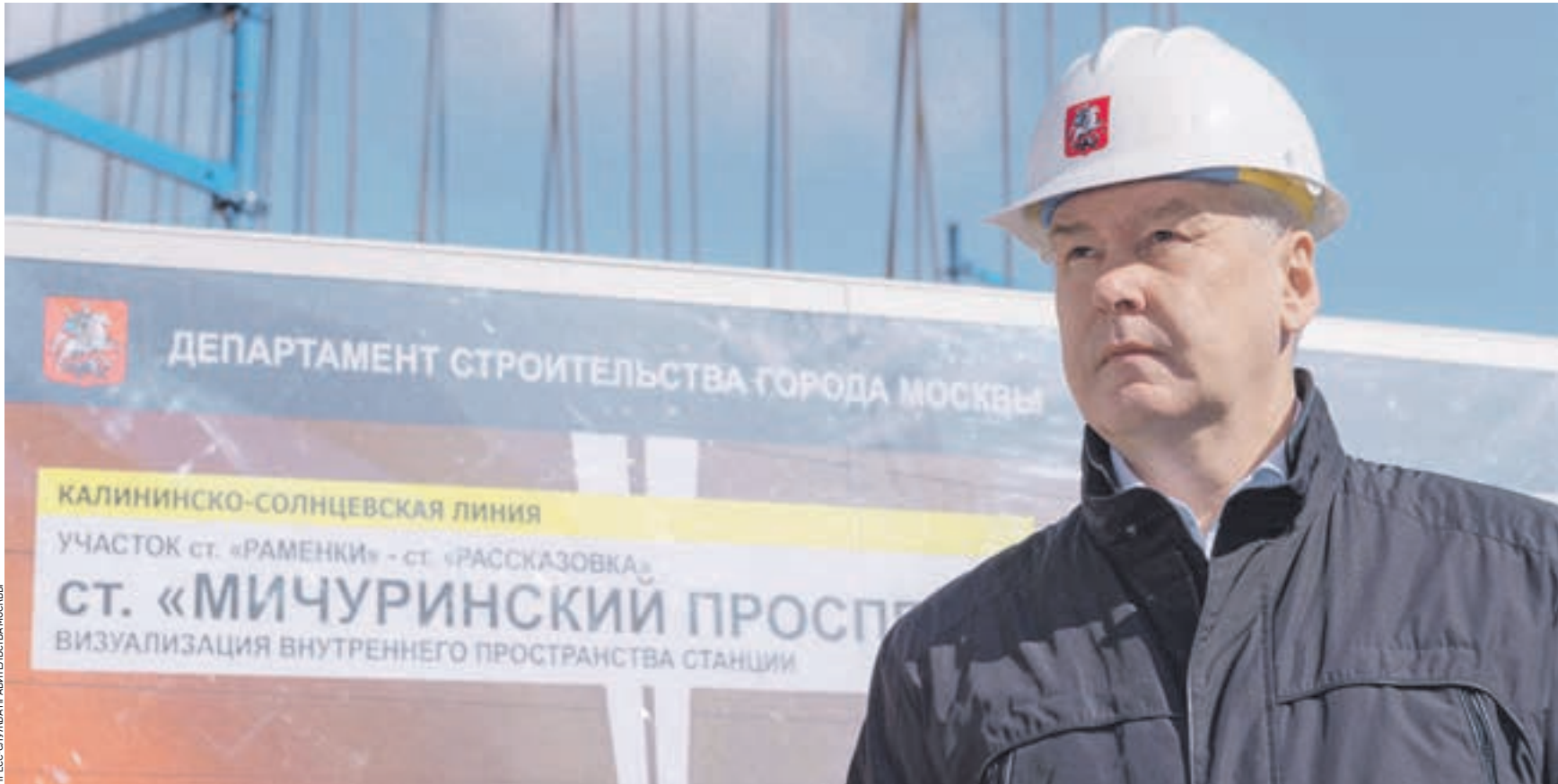
Вчера 10:41 Мэр Москвы Сергей Собянин лично проинспектировал ход работ на строящейся станции метро «Мичуринский проспект» Калининско-Солнцевской линии. Эту и еще шесть станций сдадут в следующем году в составе участка желтой ветки. Линию метро протянут до Рассказовки — деревни, расположенной в Новой Москве
