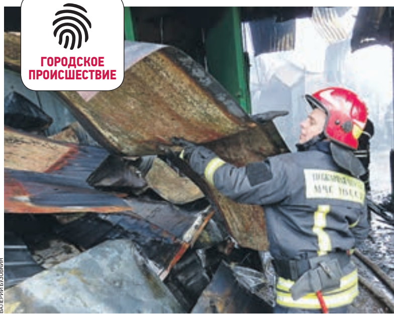
Вчера 11:15 Профсоюзная, 86. Начальник караула пожарно-спасательной части № 56 лейтенант Александр Фирсов выносит из ангара элементы кровли
