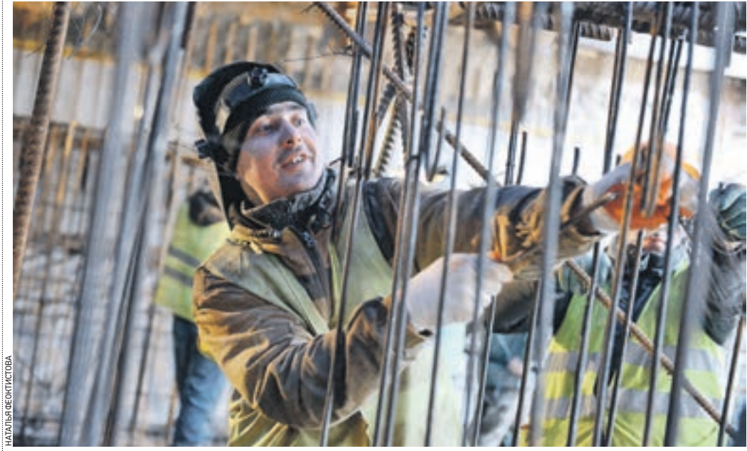
2 апреля 2016 года 12:09 Вязальщик арматуры Сергей Петров работает над основанием платформы строящейся станции метро «Терешково» («Говорово»)
