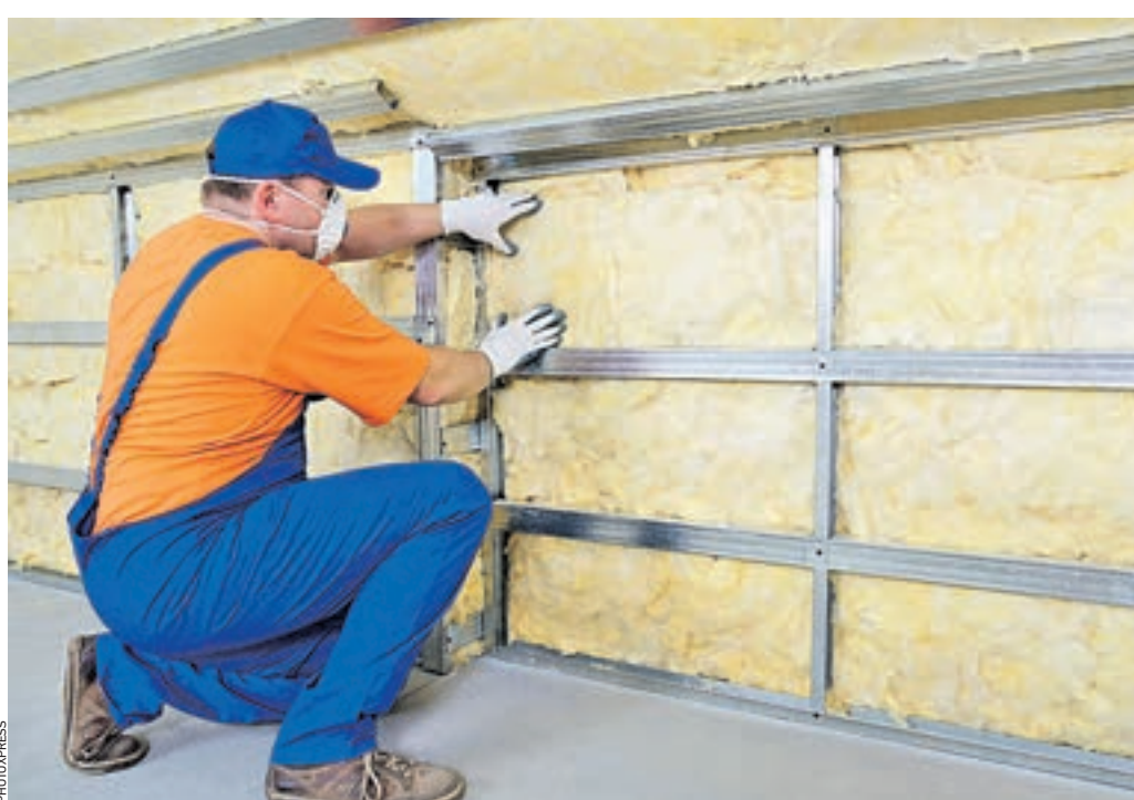
14 сентября 2016 года 12:20 Работы по внутреннему утеплению дома в поселении Крекшино на территории Новой Москвы. Строительная вата — один из наиболее популярных материалов
