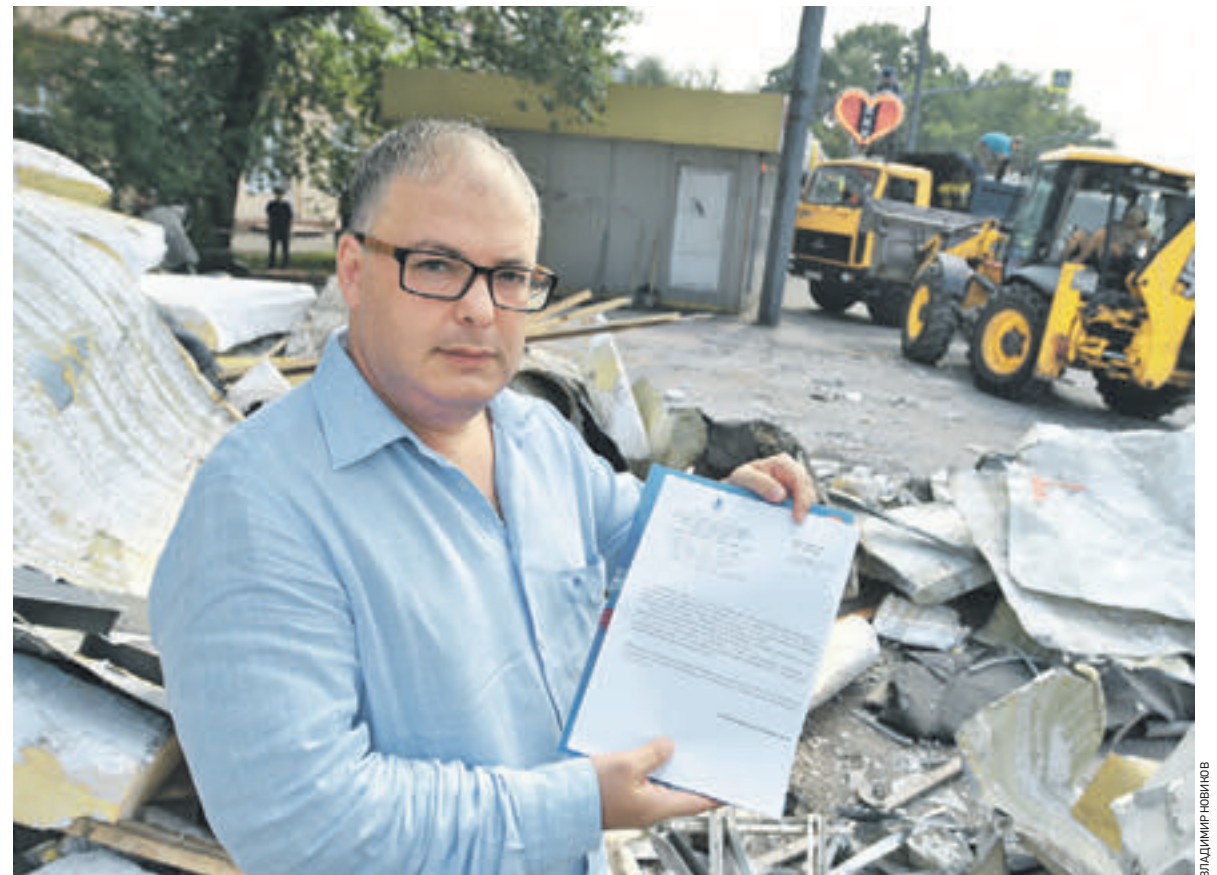
Пятница 12:20 Собственник самостроя на Бутырской улице Олег Хабнер демонстрирует уведомление Госинспекции по недвижимости о том, что объект должен быть снесен. За его спиной — обломки бывшего киоска
