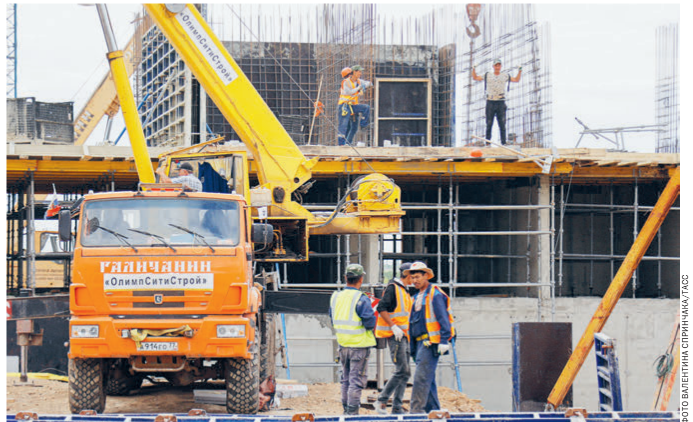
Мариуполь. Рабочие на стройплощадке жилого дома. Стройку ведет военно-строительный комплекс Минобороны РФ. Возводятся 12 пятиэтажных домов на 1011 квартир.
