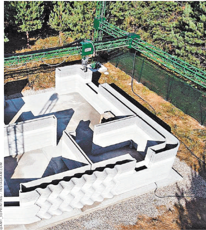
Строительные принтеры позволяют возводить здания нестандартной формы.
