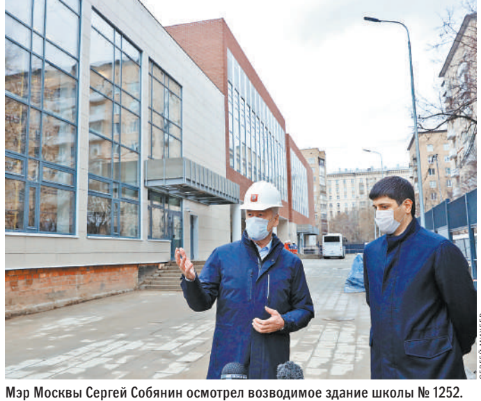
Мэр Москвы Сергей Собянин осмотрел возводимое здание школы № 1252.
