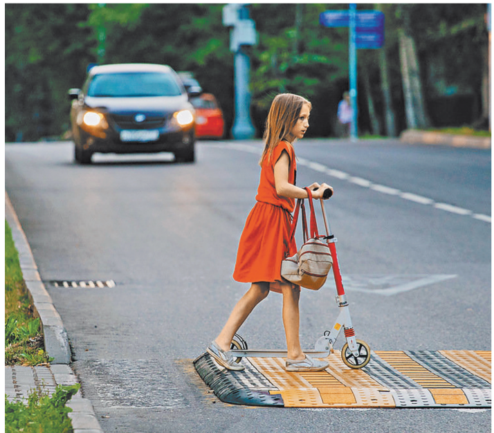
На переход, где «зебра» нанесена прямо на широкий «лежачий полицейский», уже не так страшно отпускать ребенка — он более заметен водителям.
