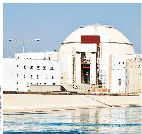
Это первый энергоблок АЭС «Бушер», а сейчас начали готовить котлован для второго.
