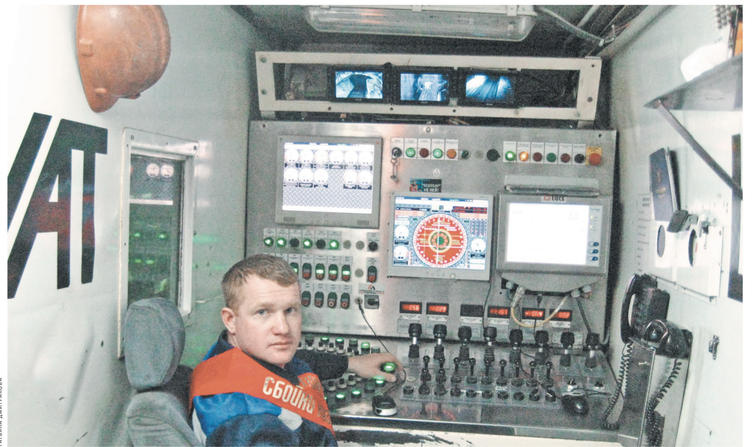
Лето 2012 года. За пультом управления тоннелепроходческого комплекса. Он работал без шума и пыли. Операторы трудились в белых рубашках.
