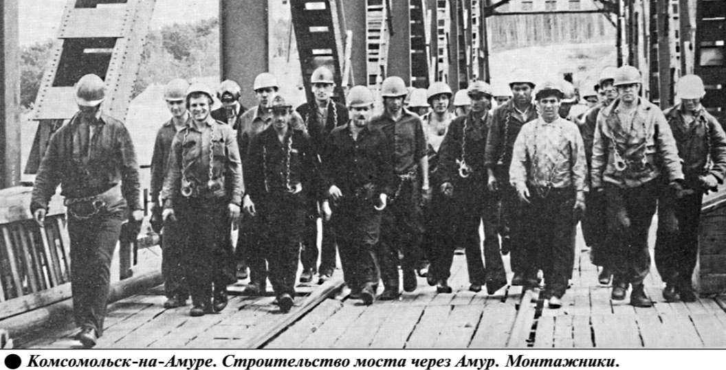
● Комсомольск-на-Амуре. Строительство моста через Амур. Монтажники.
