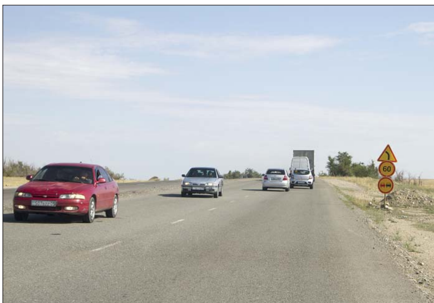
Перед населенным пунктом Кызылагаш идет строительство дороги
