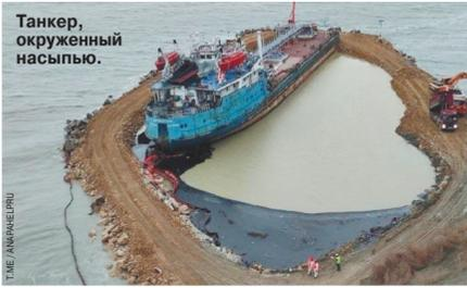
Танкер, окруженный насыпью.
