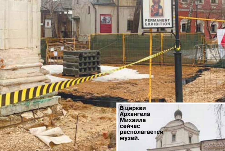
Ремонтные работы вокруг музея-церкви.
