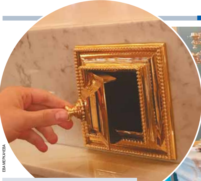
Через такие отверстия теплый воздух издревле поступал в помещения Кремля и обогревал их.
