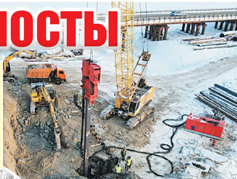
Реконструкция мостового перехода через протоку Чеускино вблизи Нефтеюганска. Рядом построен временный мост.
