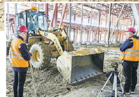
ООО «РСК» готово проявить себя и в промышленно-гражданском строительстве.
