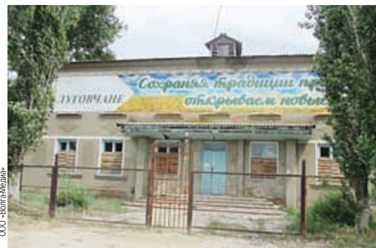
Восстанавливается здание бывшей конторы совхоза.
