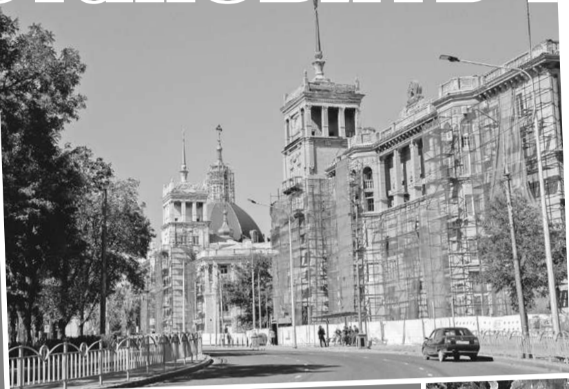
Мариуполь будто рождается заново. Там, где еще год назад стояли руины (фото справа), сейчас - строительные леса.
