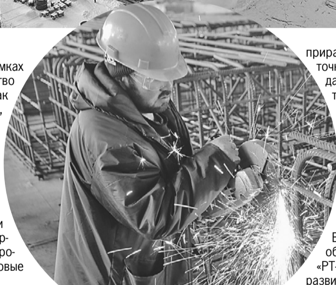
Монтаж оборудования на высокотехнологичном предприятии - дело тонкое.
