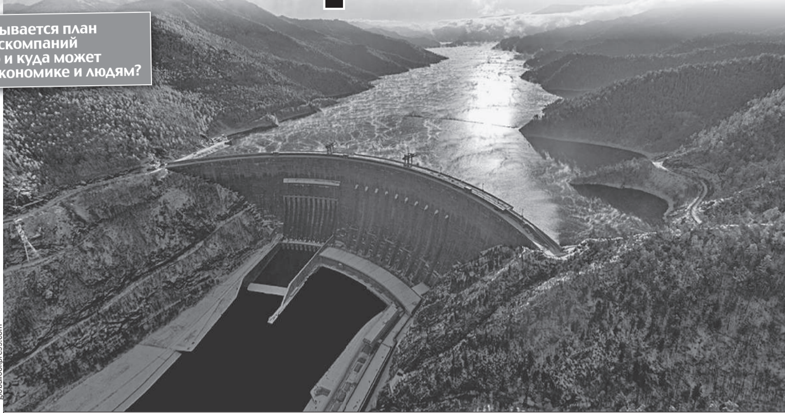
Саяно-Шушенская ГЭС - крупнейшая по мощности электростанция России. Не пора ли нашим энергетическим гигантам переехать поближе к этому источнику энергии?
