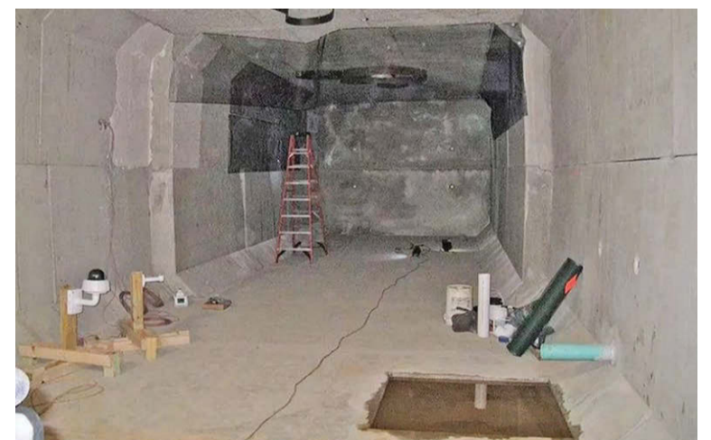
Сложность работ заключается в грунте: чем он мягче, тем быстрее и дешевле обойдутся работы.
