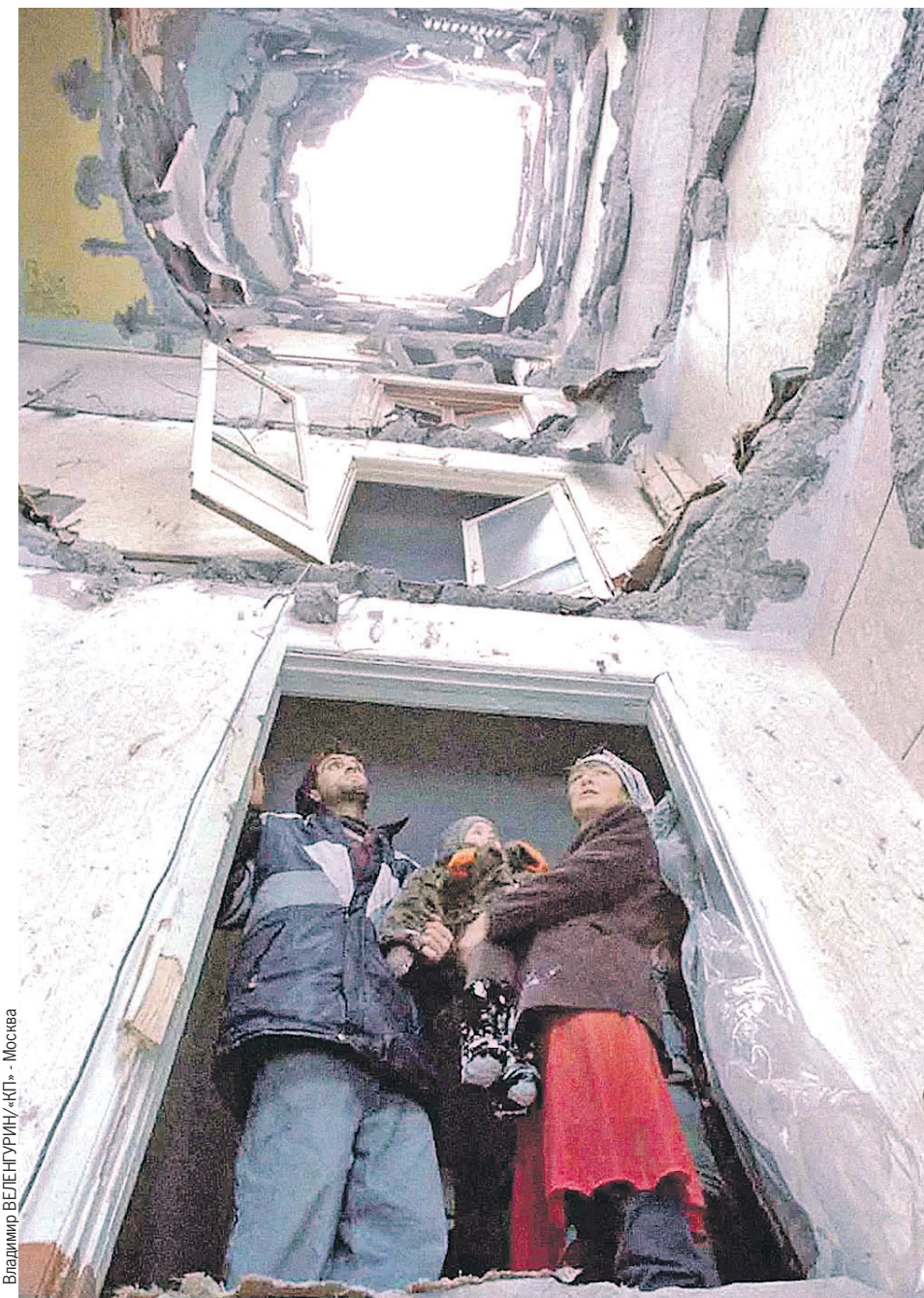
Разрушенный дом в Грозном. В то же время массовых притеснений русских в дудаевской «Ичкерии» словно не замечали...
